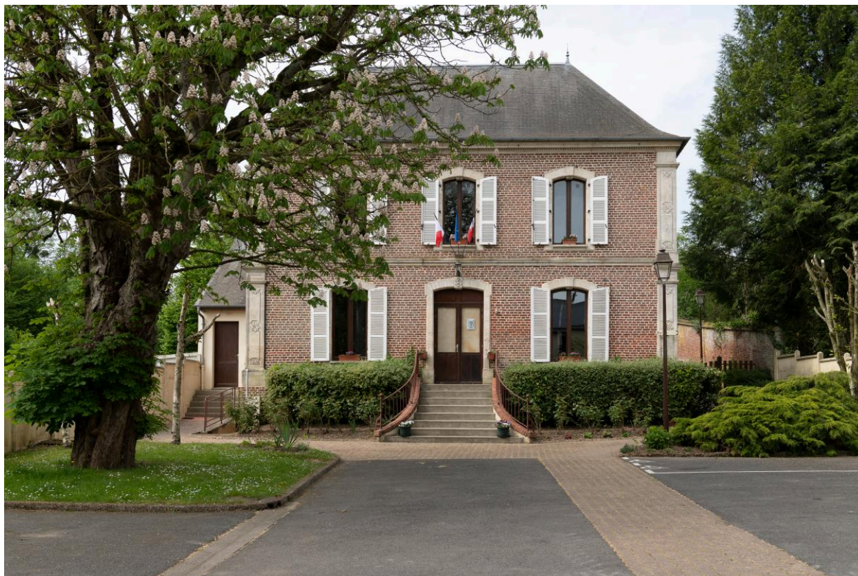
Mairie (ancien presbytère), Rue Principale, vue depuis le nord-est.
