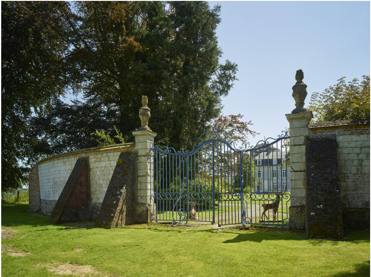
Grille d'accès depuis le château avec la façade nord du château en arrière-plan.
