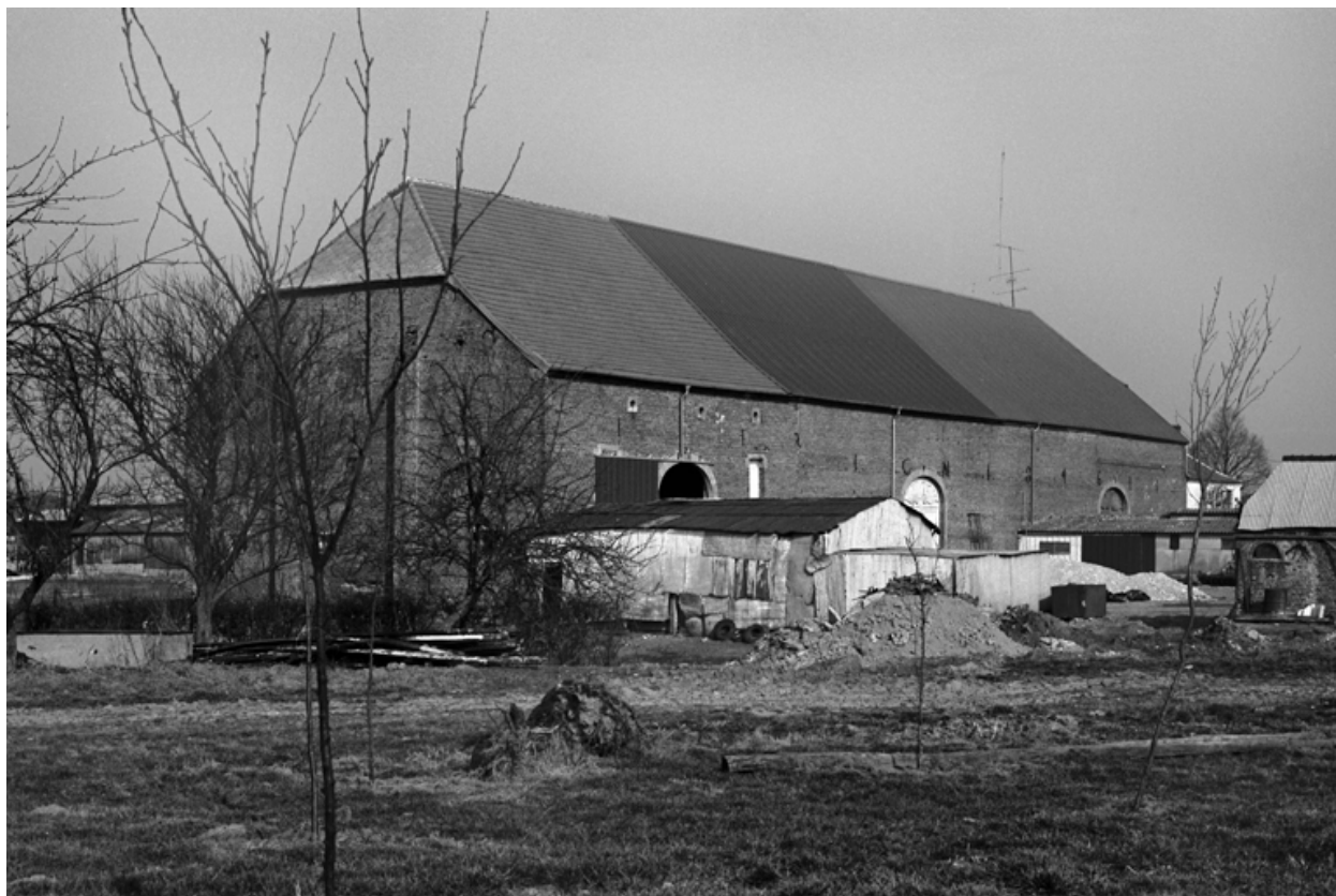
Vue générale sud de la grange.
