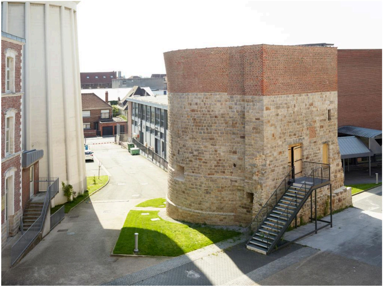
Vue en détail du nord-est de la tour, prise depuis les étages du lycée.
