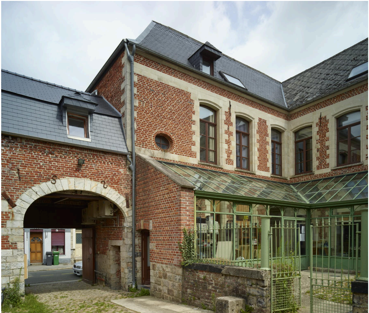
Détail de la jonction entre la maison et l'aile accueillant le porche : vue depuis la cour.
