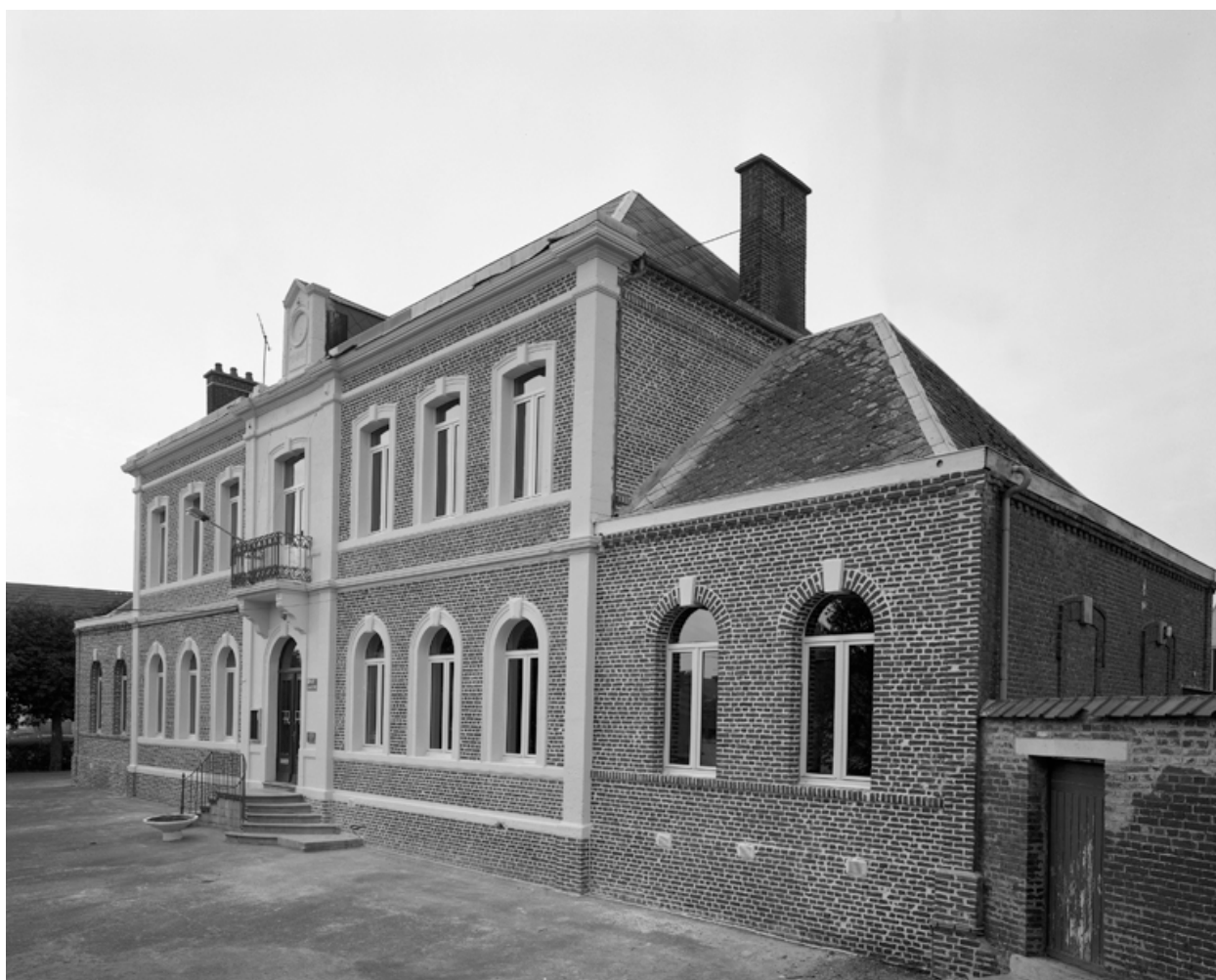
Vue d'ensemble de la façade.
