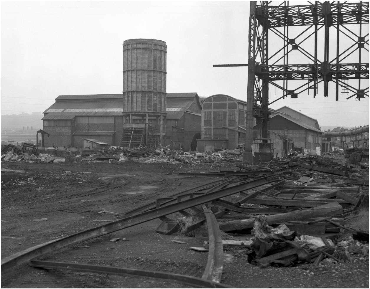
Vue d'ensemble (magasin général, réfrigérant, turbos, redresseurs).
