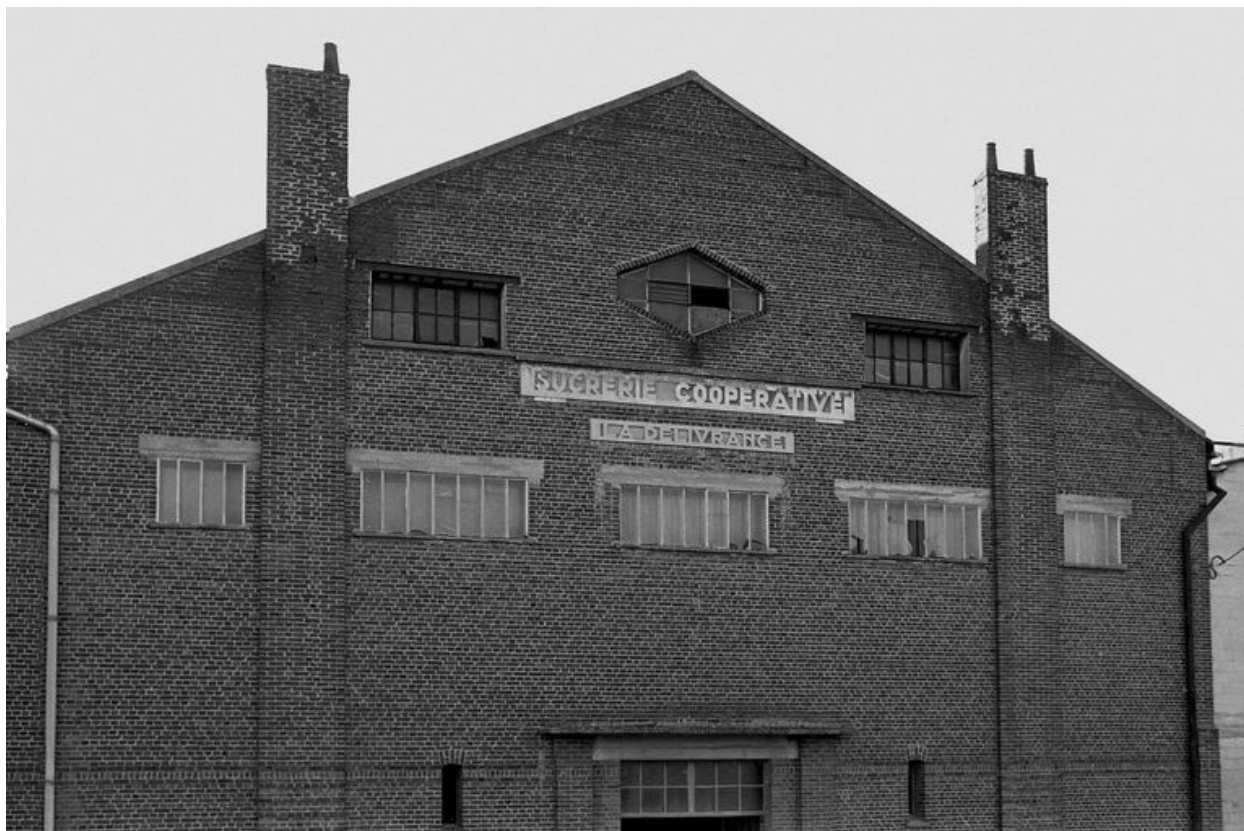
Atelier principal, flanc sud : détail.
