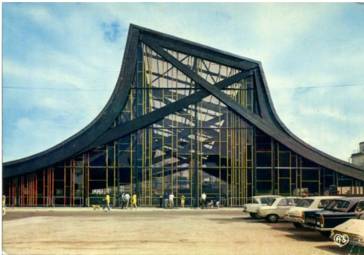
Vue de la façade vitrée et de la charpente en bois lamellé-collé de la piscine de Berck-Plage, carte postale, vers 1970 (coll. part.).
