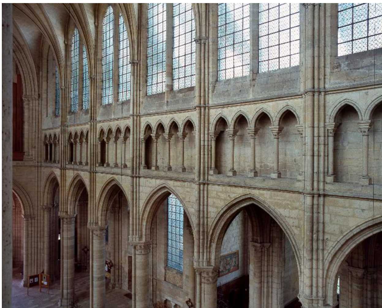
Vue du triforium nord de la nef.
