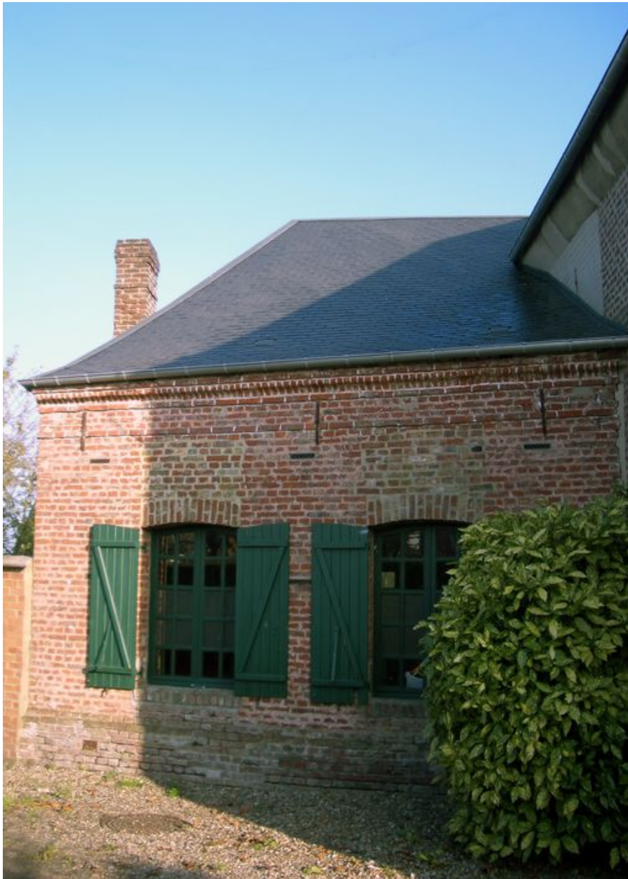
Vue de l'annexe flanquant le mur pignon nord.
