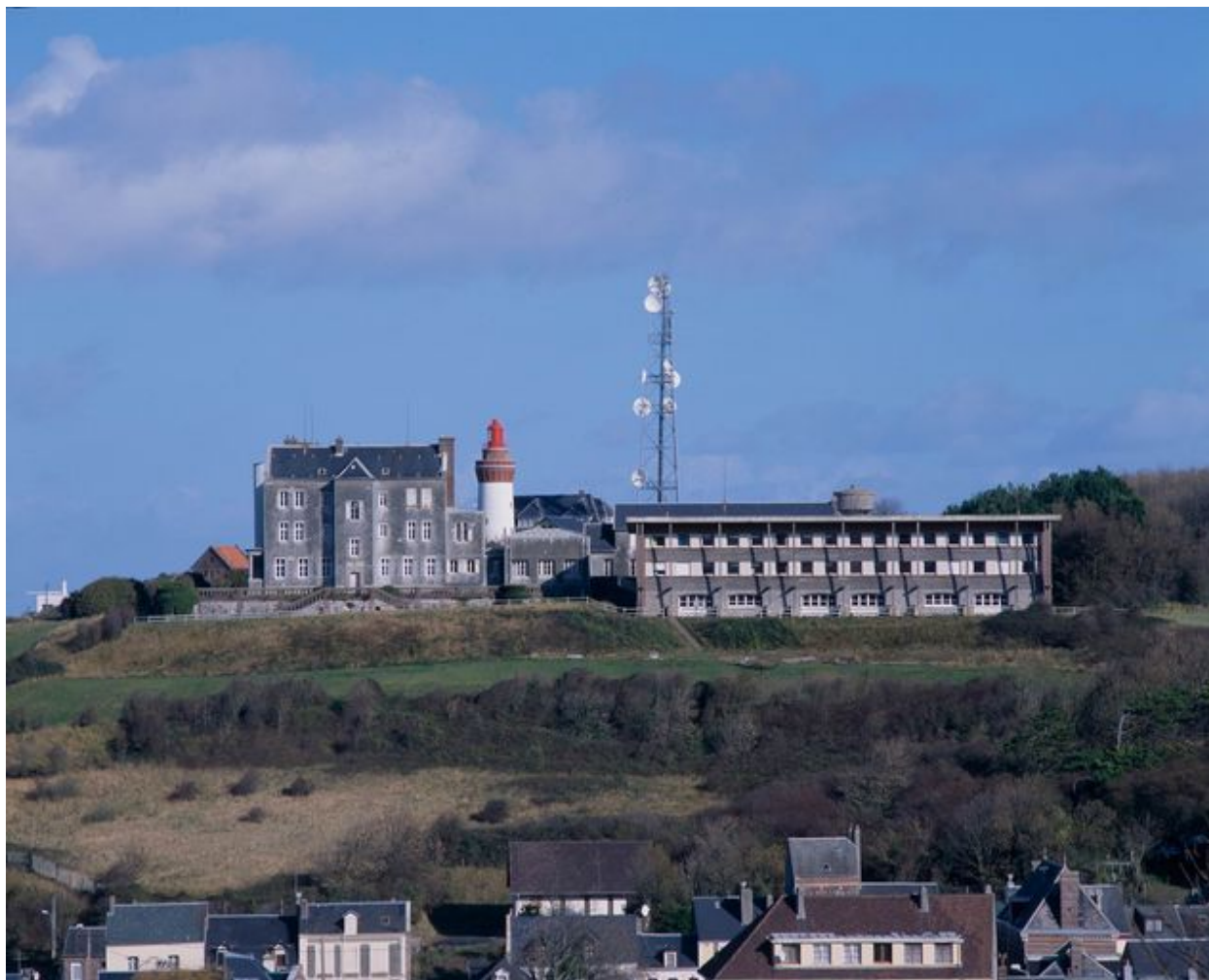
Vue d'ensemble depuis le lotissement du Bel-Air.
