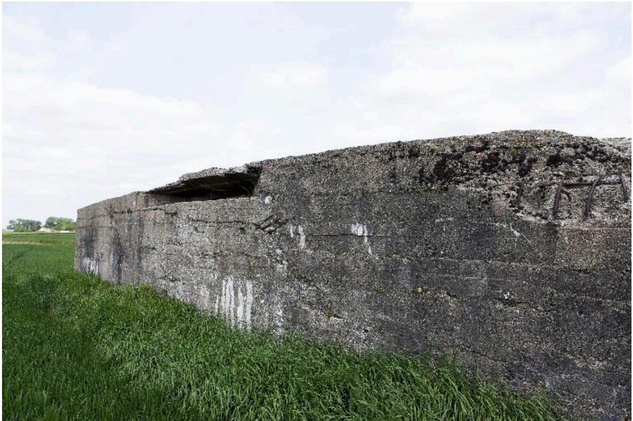
Elévation postérieure vue de trois-quarts vers le nord-est
