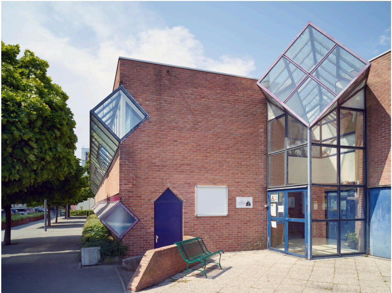
La façade sur la rue Vermeer depuis l'angle sud-est du groupe scolaire.
