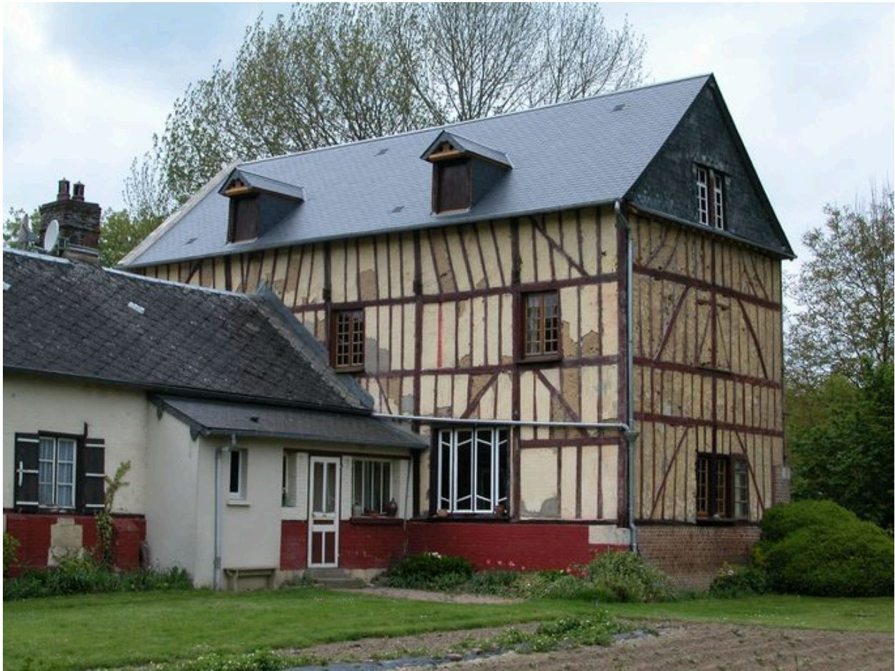
Vue d'ensemble du moulin, façade antérieure.
