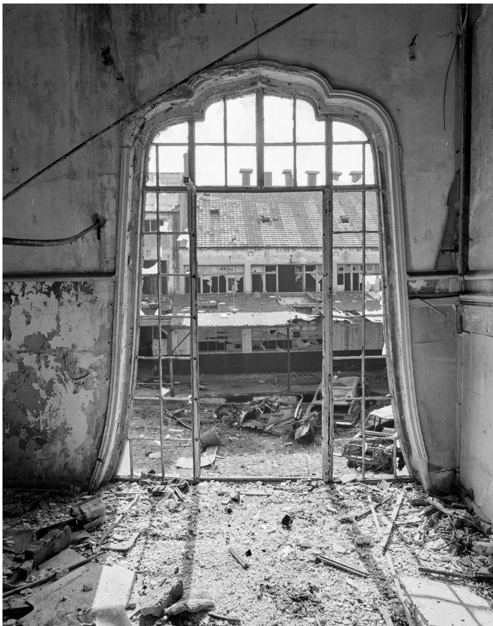
Porte-fenêtre : vue de l'intérieur.
