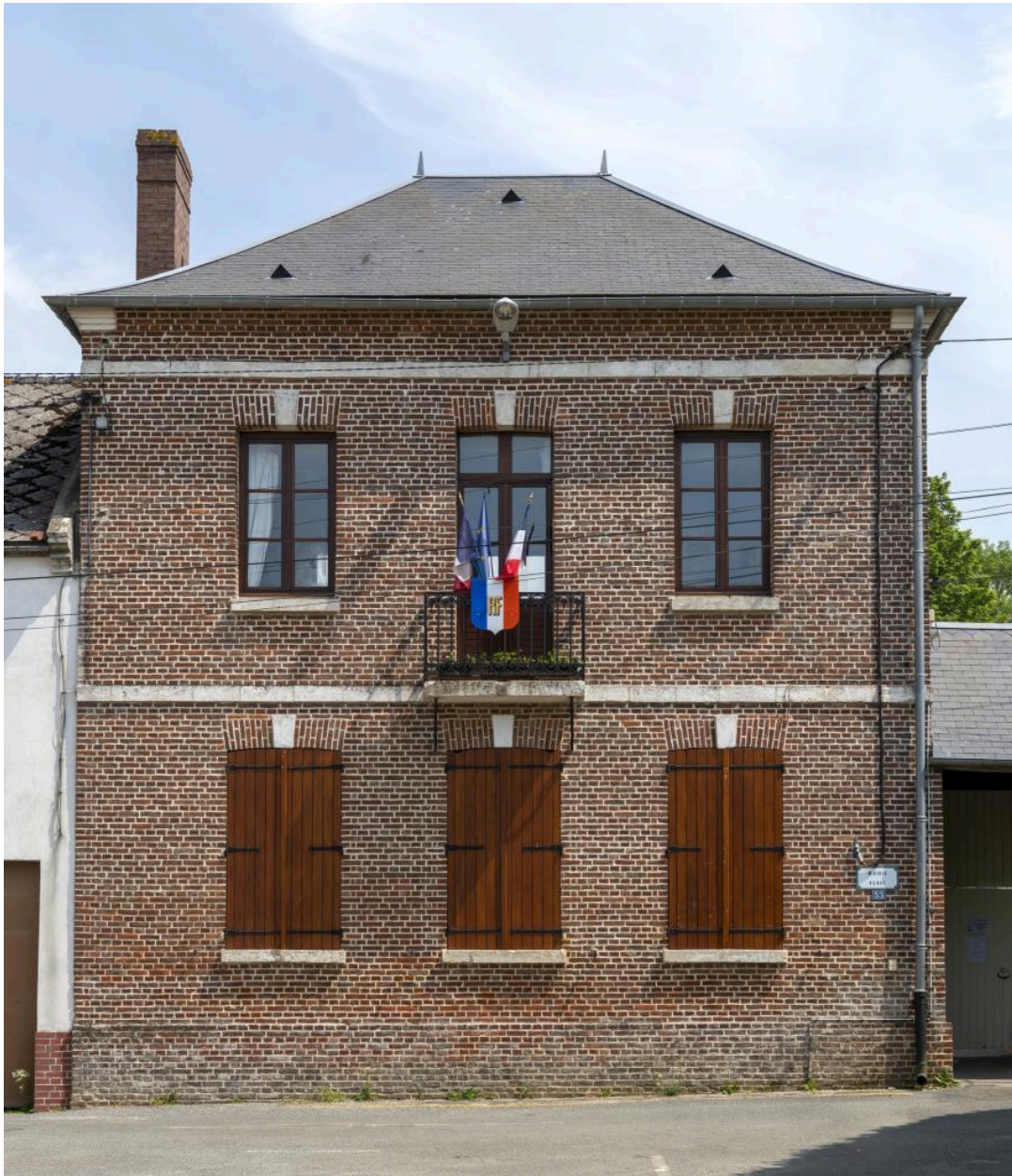
Mairie, façade ouest, n°53 rue Principale, vue depuis la rue.
