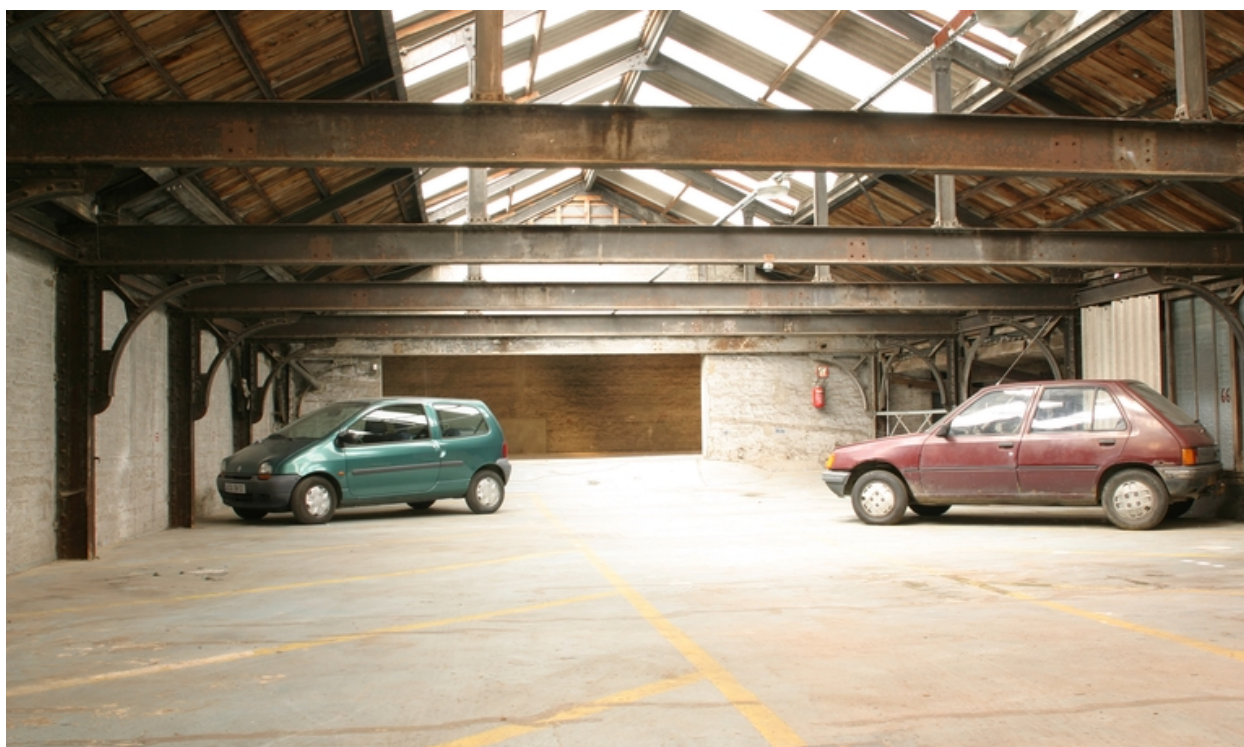
Ancien atelier d'usinage.
