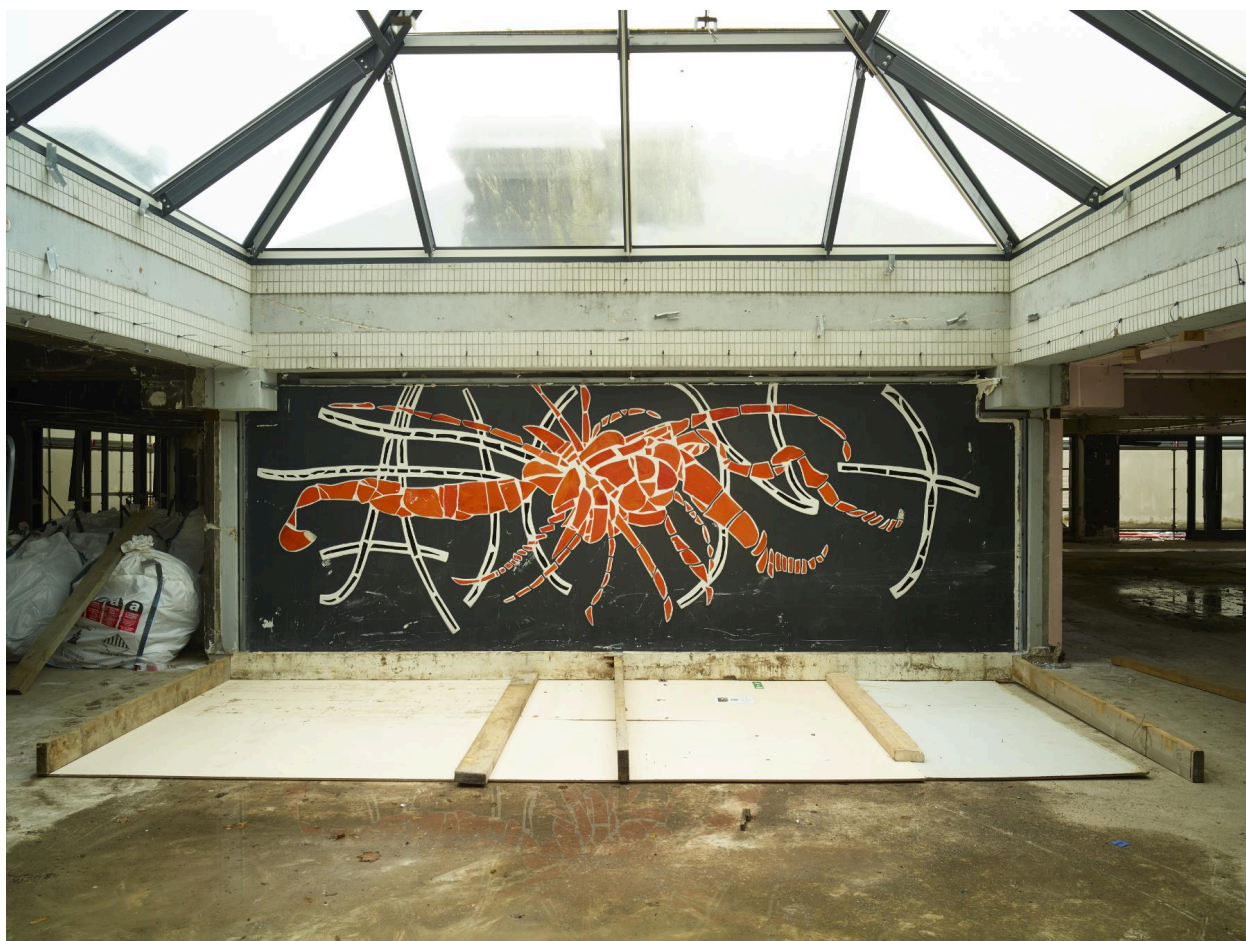
L'œuvre murale Le Homard d'Arthur Van Hecke (1924-2003), après le début des travaux.
