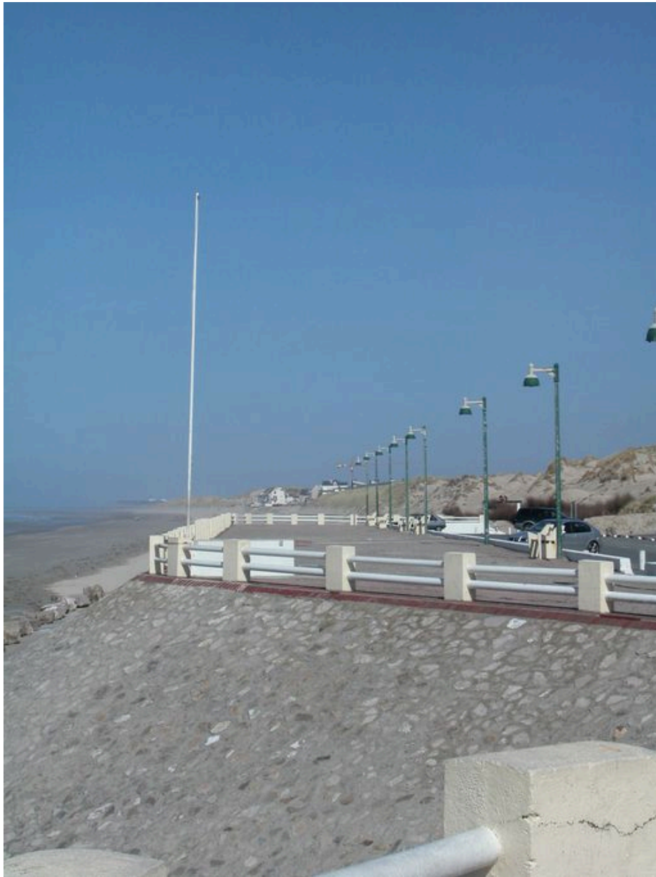
La digue nord, vue depuis le sud.
