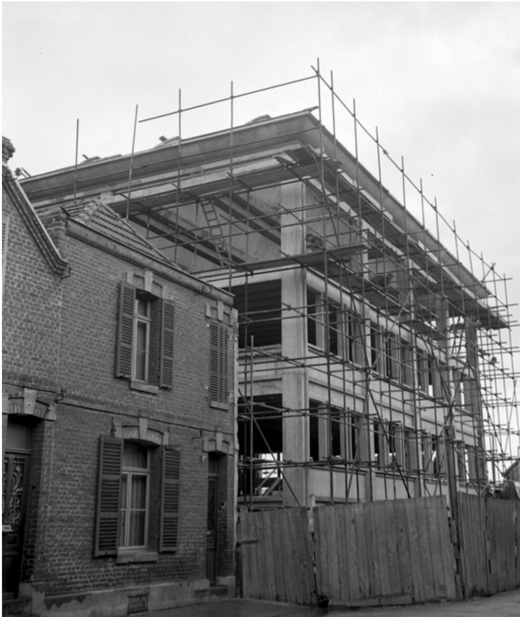
Les services généraux en construction, vers 1950 (IFA).
