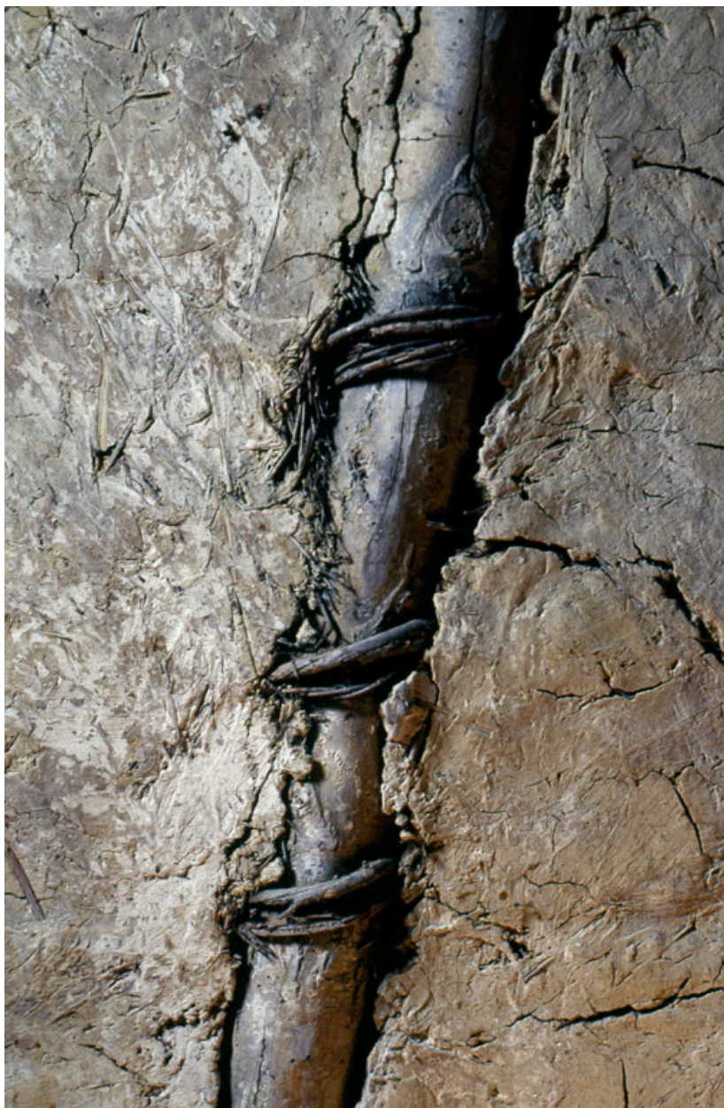
Barzy-en-Thiérache, ferme (repérée), 30 rue Neuve : détail d'une cloison en torchis dans le comble du logis.
