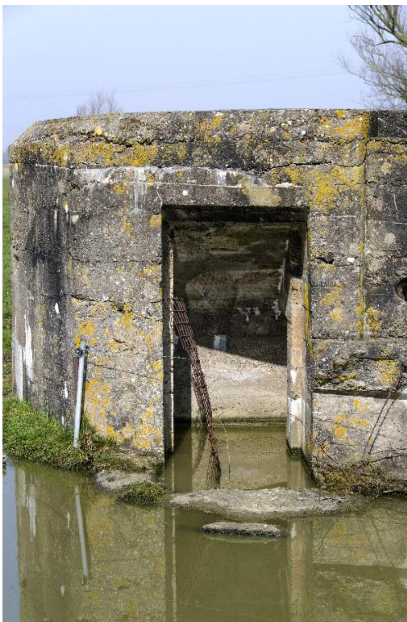
Elévation sud, entrée ouest
