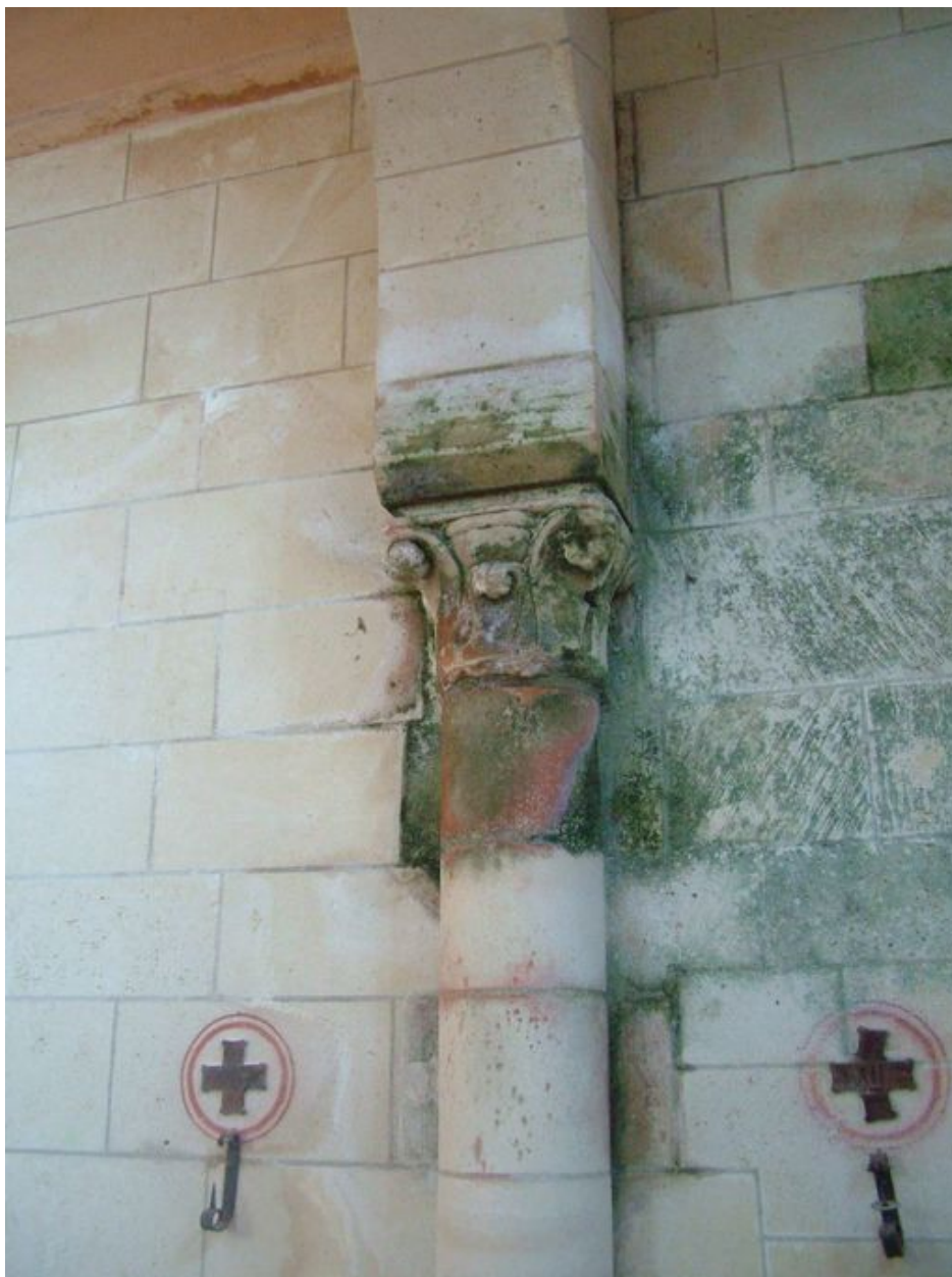
Vue d'un chapiteau du 13e siècle.
