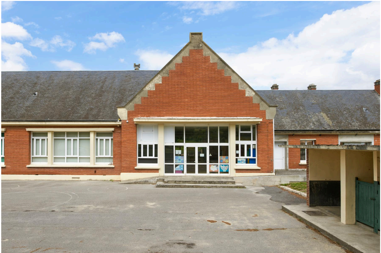
Vue sud de l'entrée de l'école.
