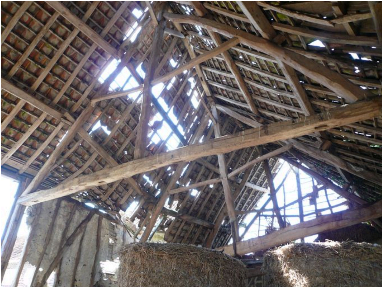
Vue d'une ferme de la grange.
