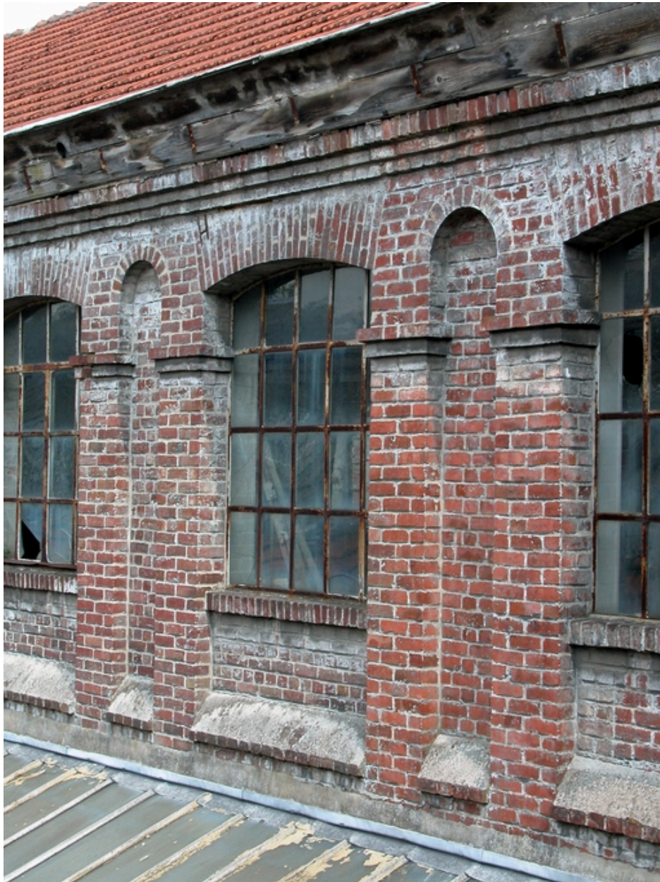
Façade postérieure des ateliers de fabrication de guipure, construits en 1887, détail.
