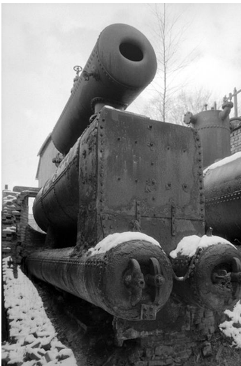
Chaufferie, chaudière à vapeur (Louis Fontaine).
