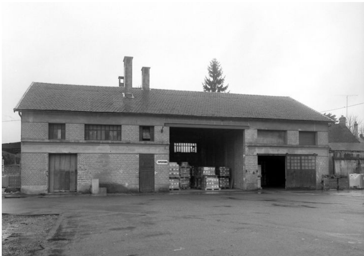
Salle des machines, façade latérale nord.
