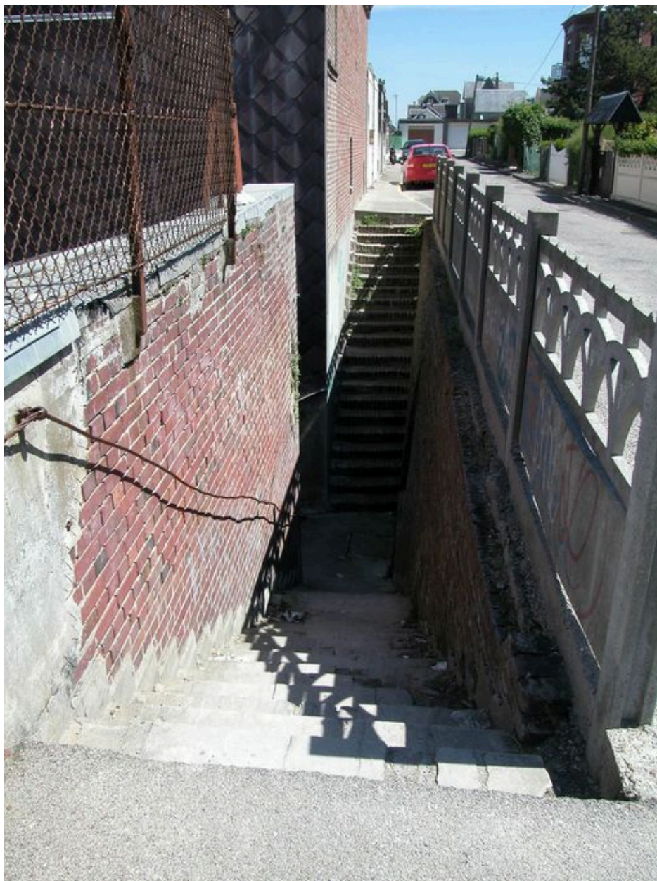
L'escalier d'accès entre la rue de la Terrasse et la rue de Saint-Valery.
