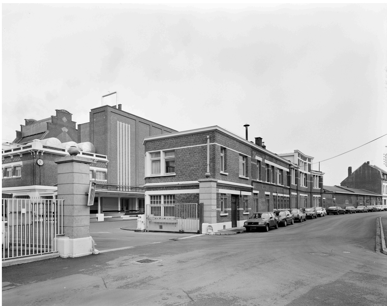
Bureaux, élévation rue Pierre-Brossolette.
