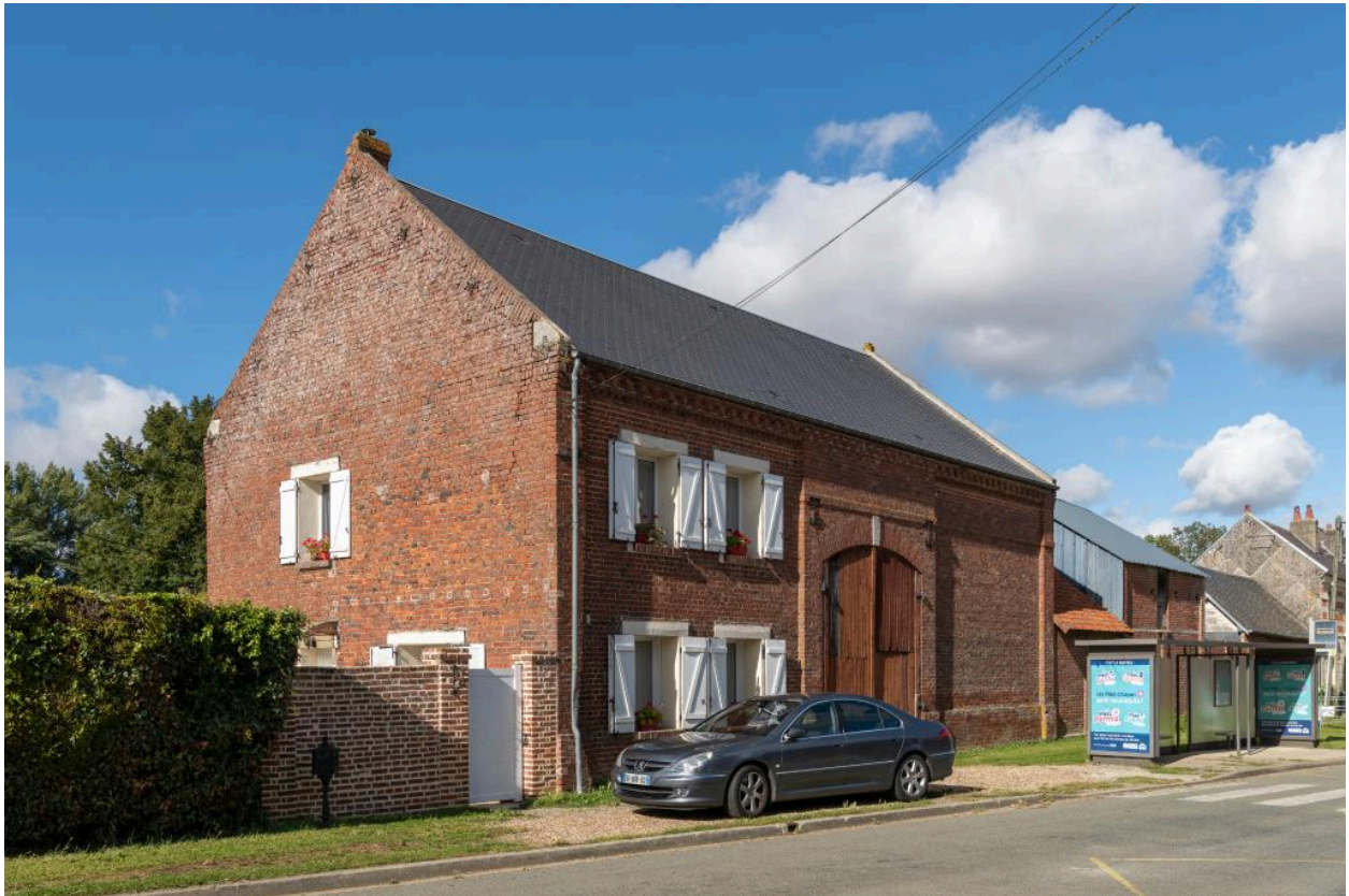
Logis et entrée charretière d'un ancien commerce, n°52 Grande Rue, vue depuis le sud-est.
