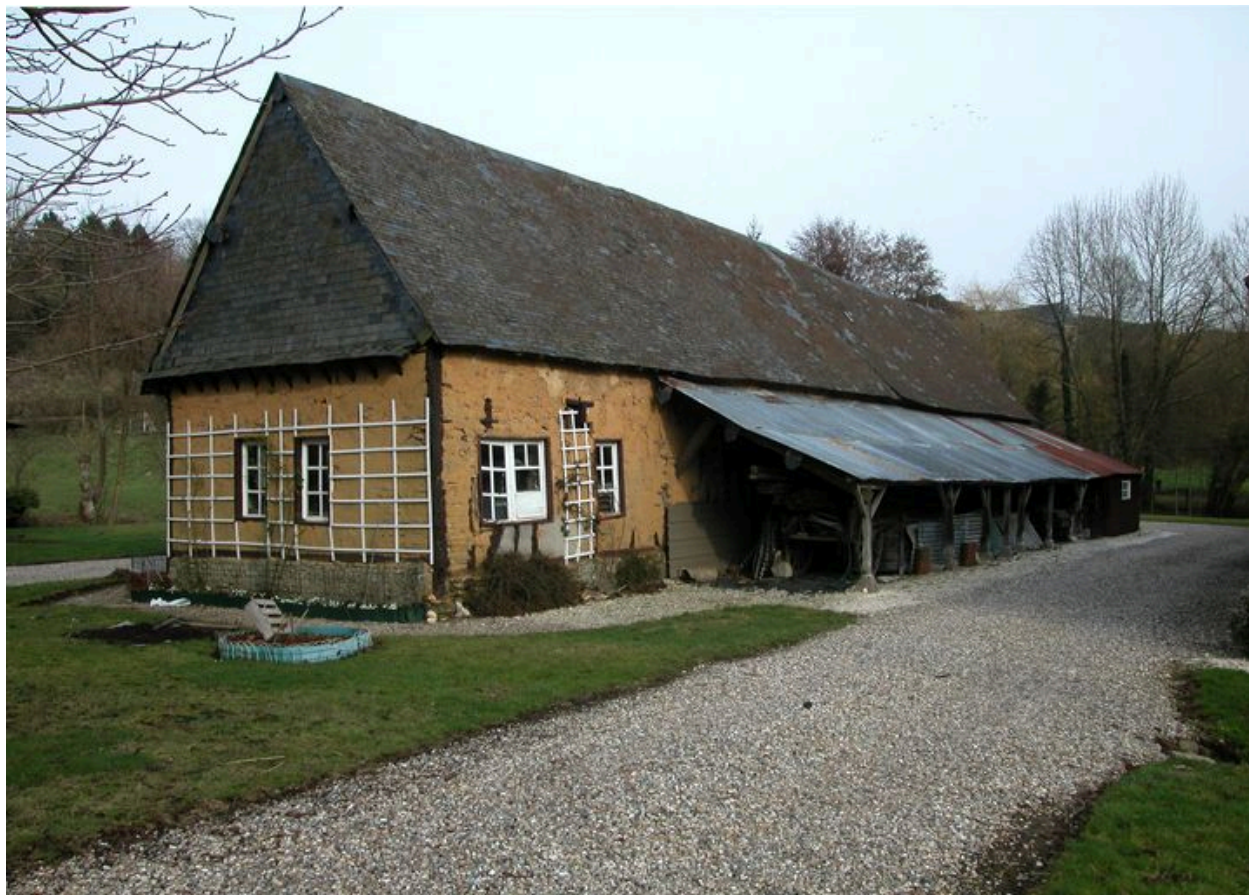
Atelier de montage des caisses, vue d'ensemble.
