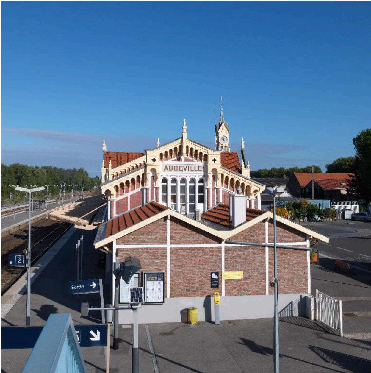
Vue depuis la passerelle.
