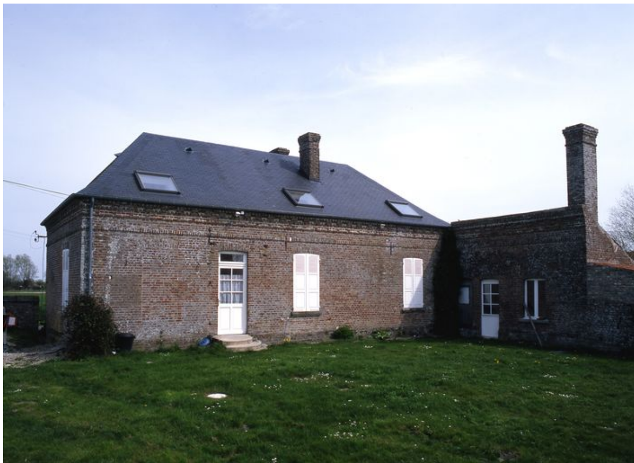
Vue postérieure de la maison.
