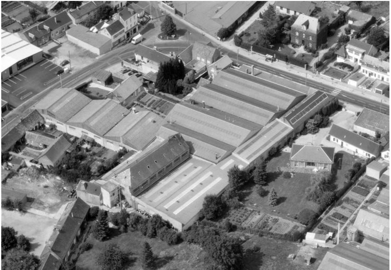
Vue aérienne en 1988, flanc sud-est.
