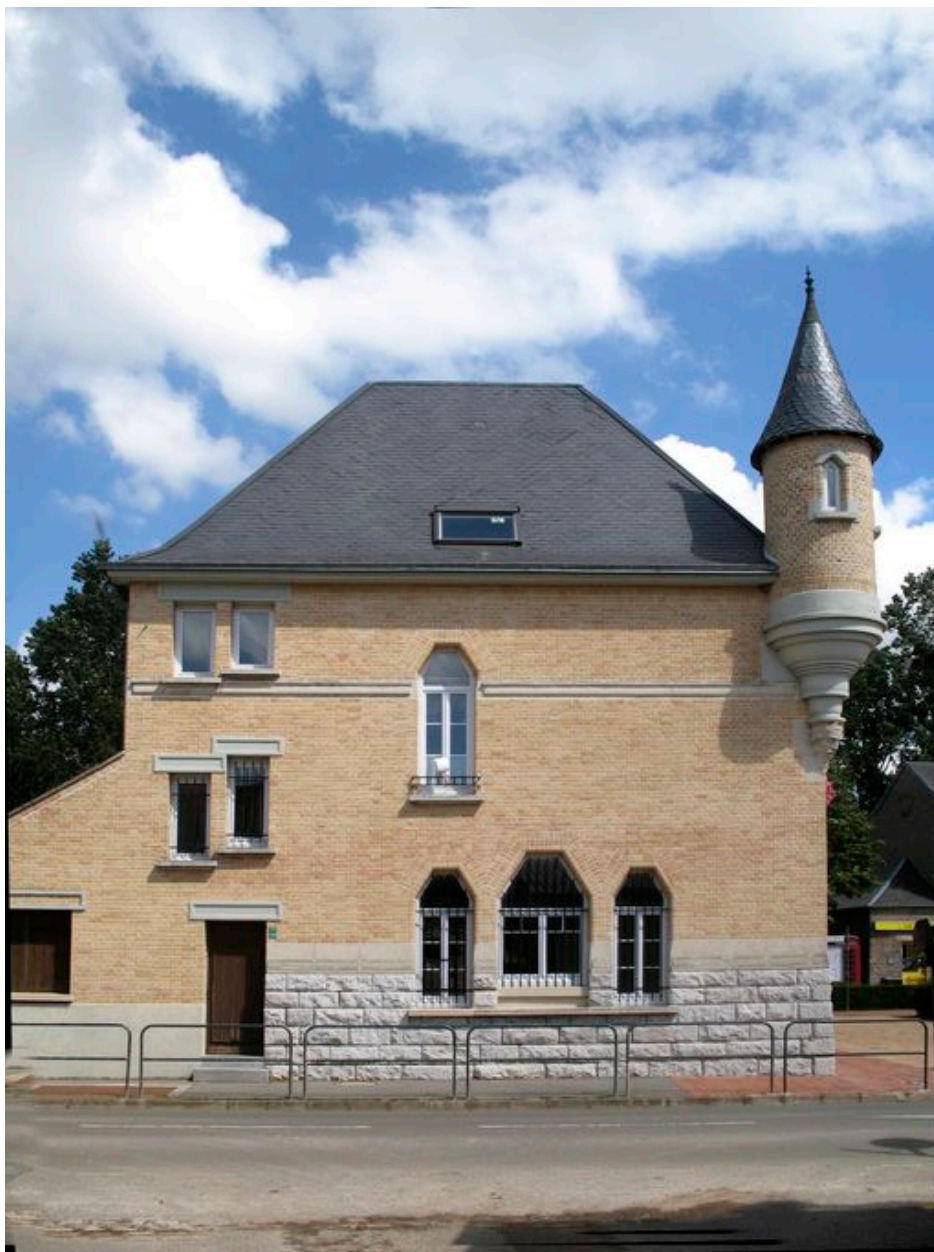
Elévation latérale sud.
