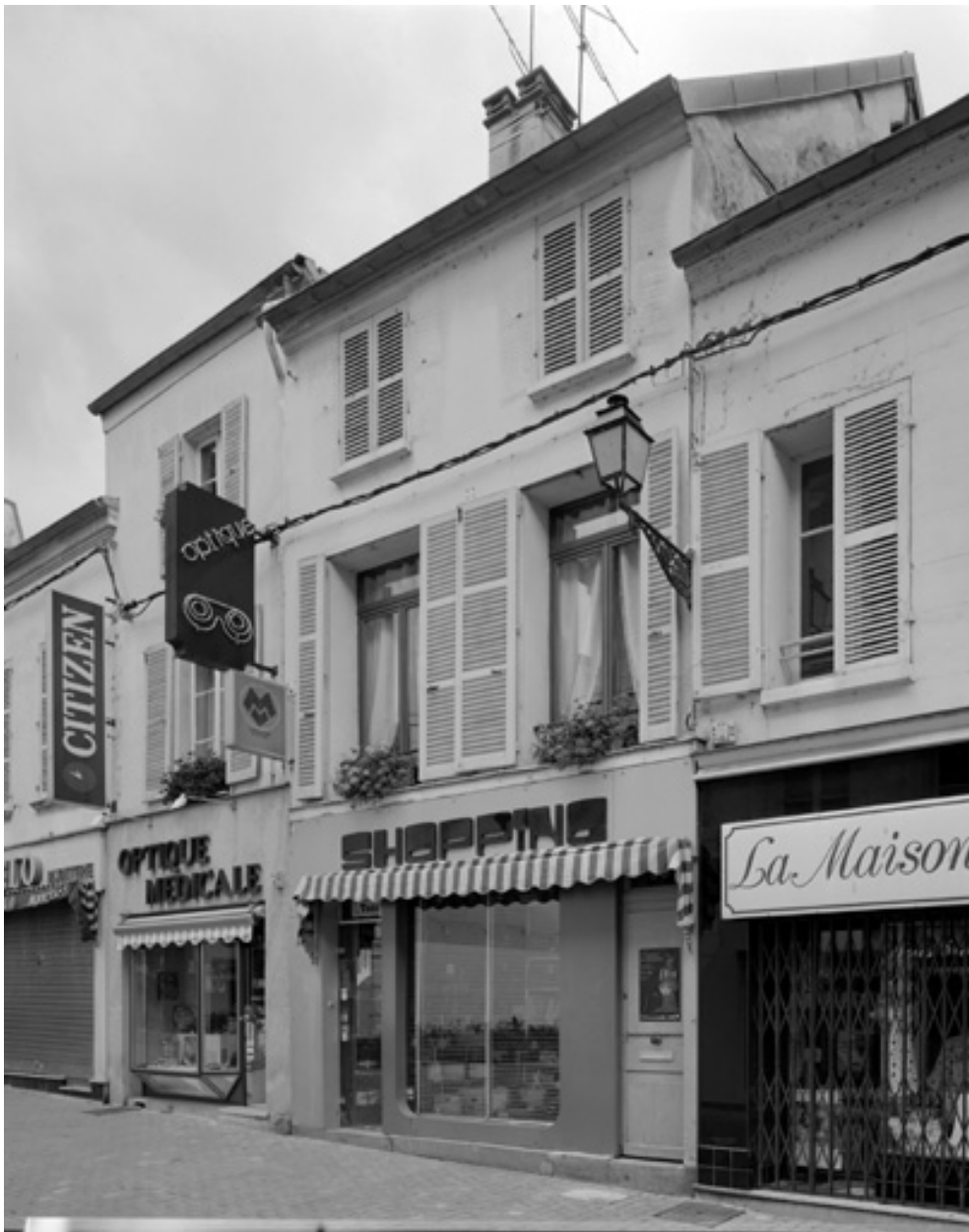
Vue de la façade sur la rue.
