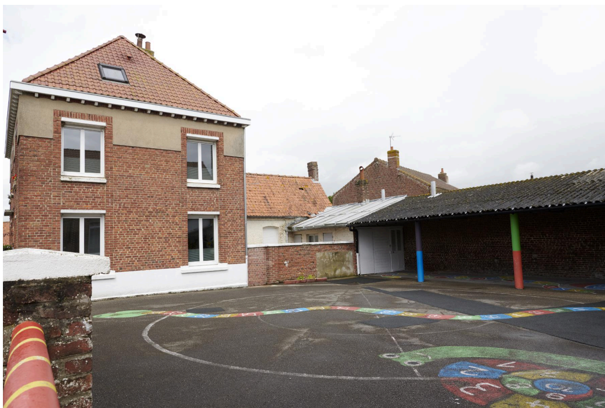
Ancien logement de l'instituteur, façade sur cour.
