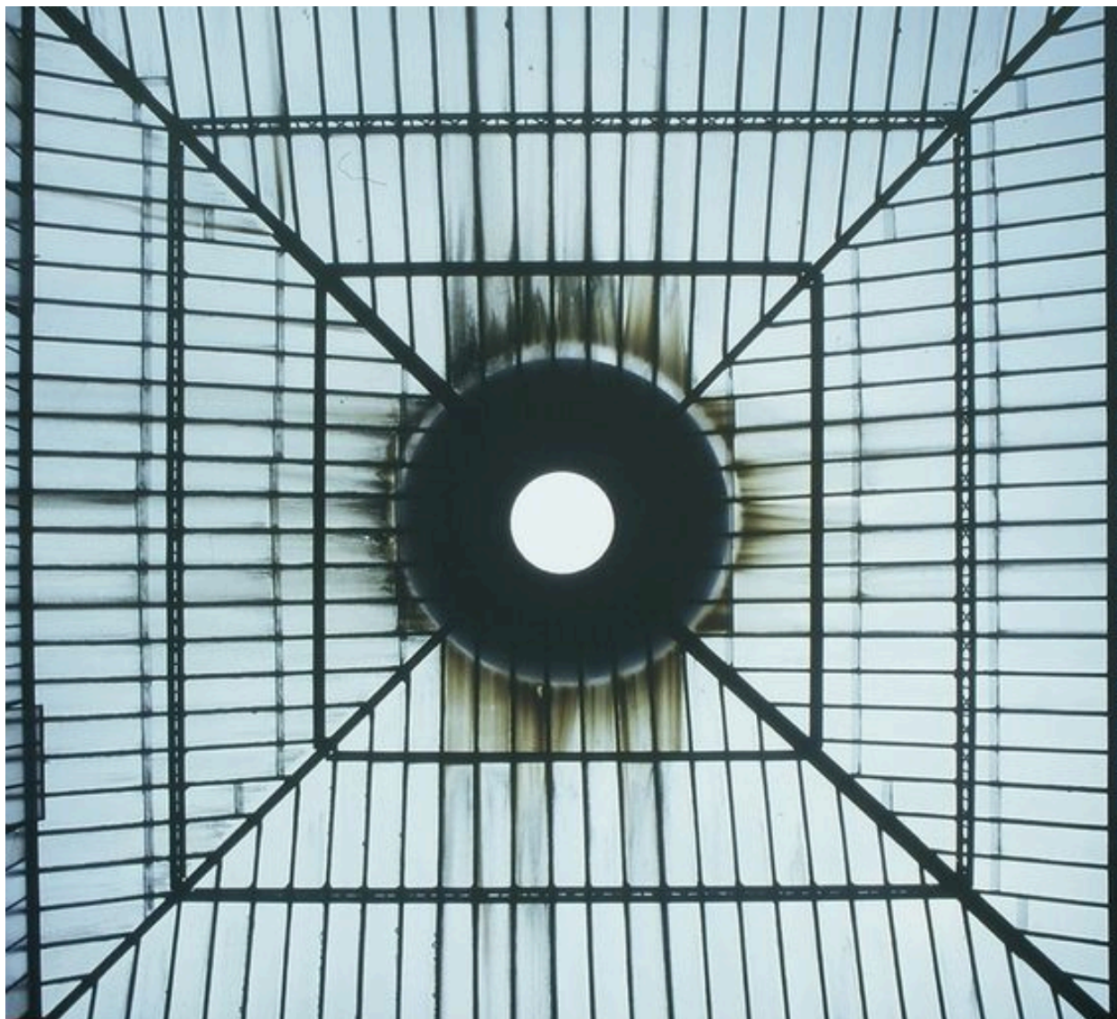
Détail de la verrière du lanternon.
