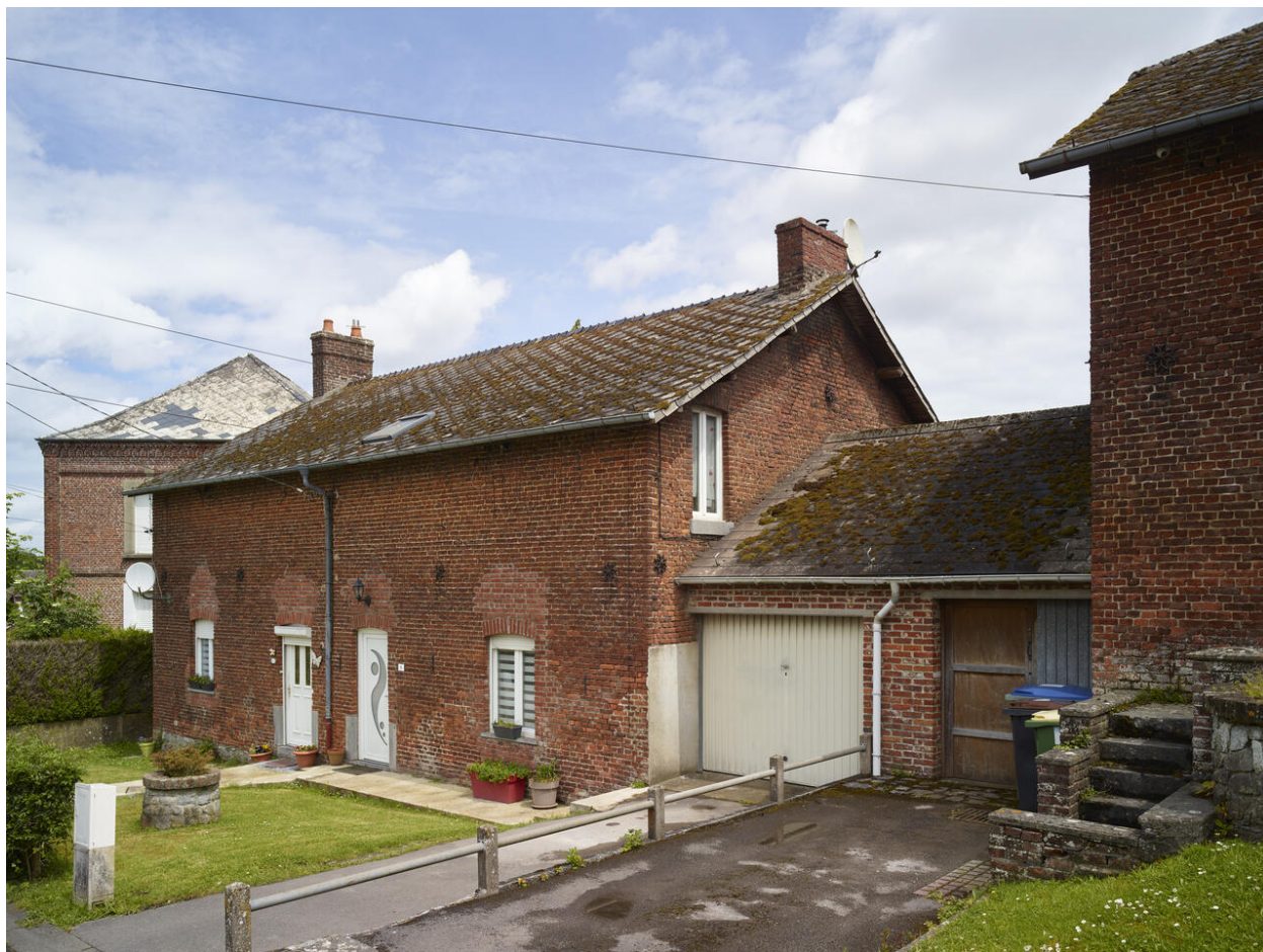
Logements d'ouvriers (9-11 rue du Moulin).
