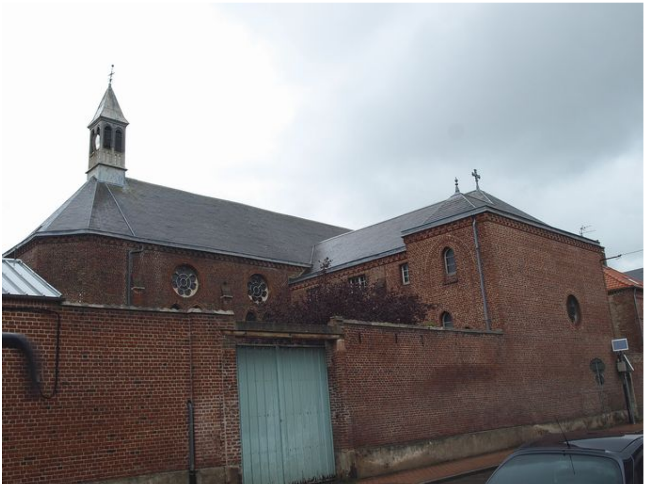
Flanc gauche depuis le rue de Therouanne
