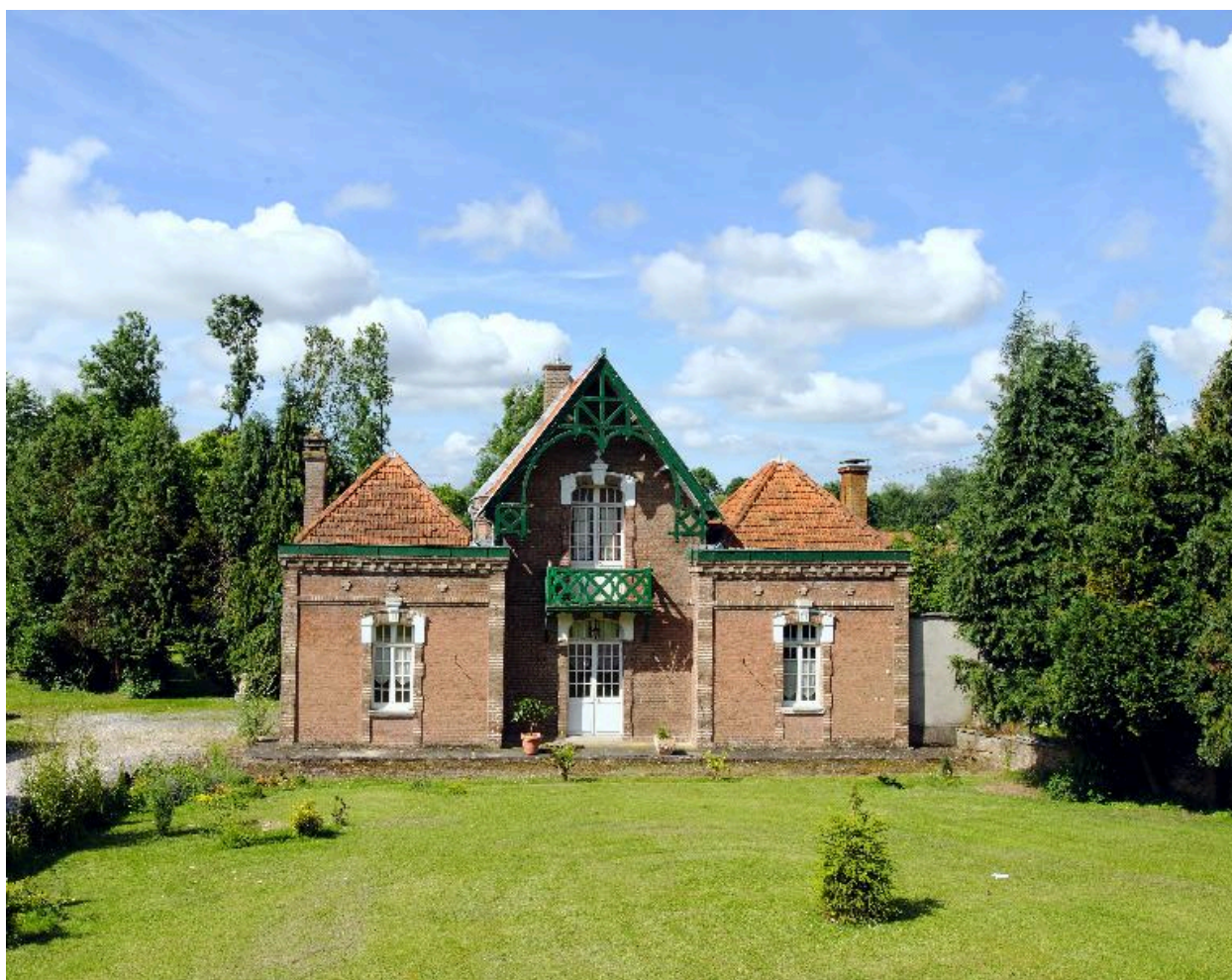
Ensemble sur rue, vue de face.
