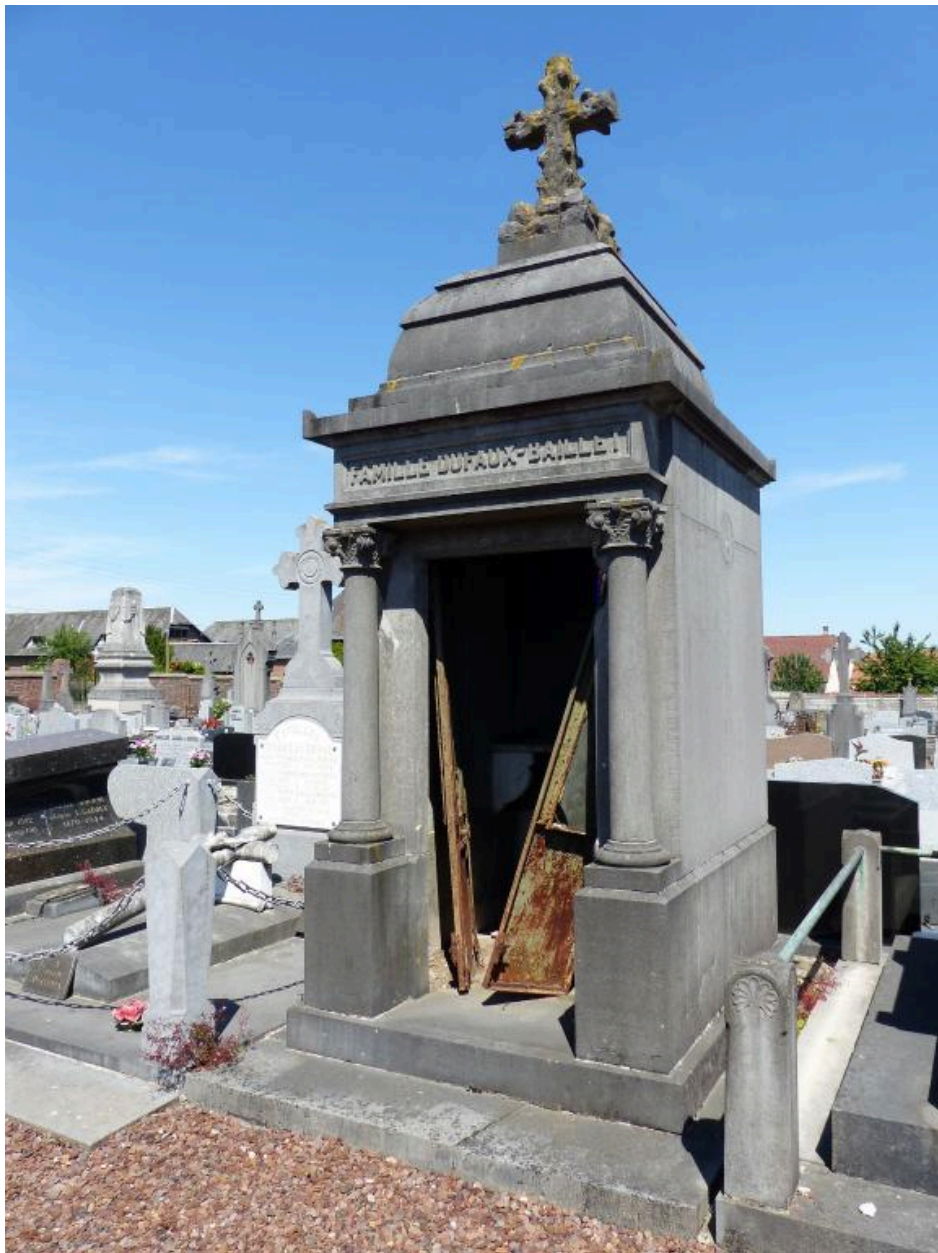
Plaine G (100). Tombeau (chapelle) de la famille Dufaux-Baillet. Gaudier-Rambaux - Aulnoye - Nord (marbrier). Piètement Rembaux et Cie - Aulnoye - Nord (marbrier).
