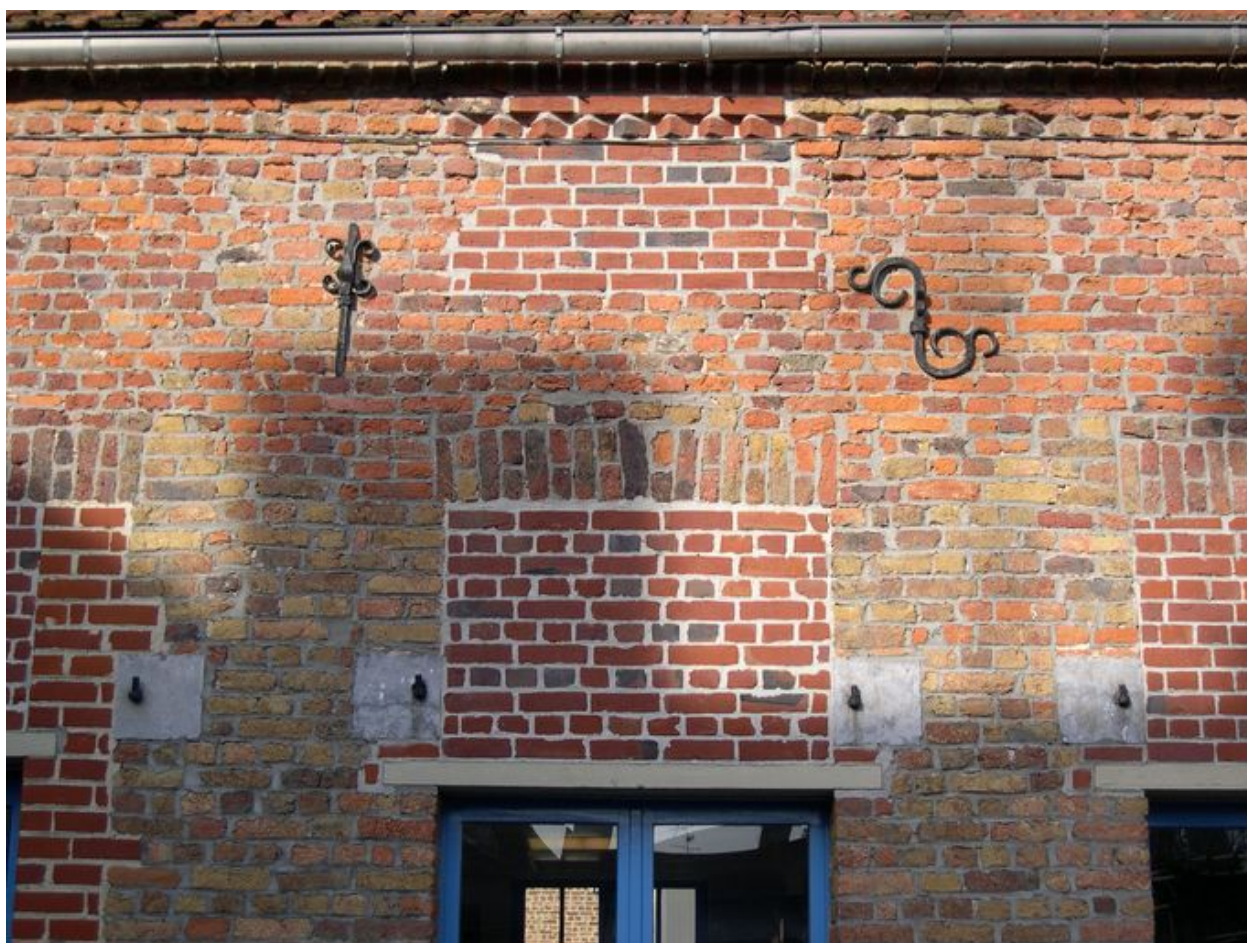
Vue depuis la cour de l'école des filles : corps de bâtiment donnant sur la rue Neuve, traces des anciennes baies, fers d'ancrage ouvragés et corniche en dents de scie.
