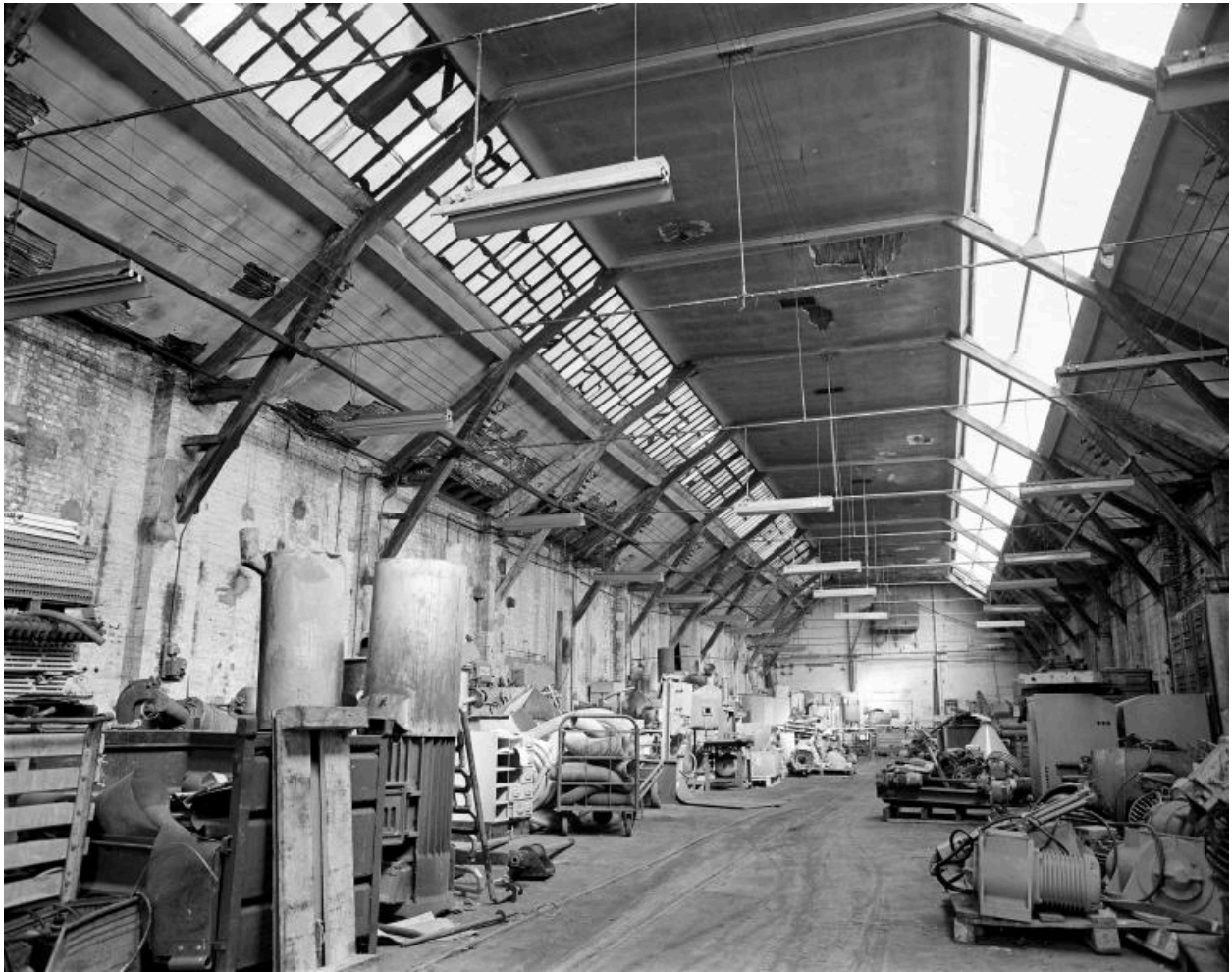
Vue intérieure d'un entrepôt industriel.
