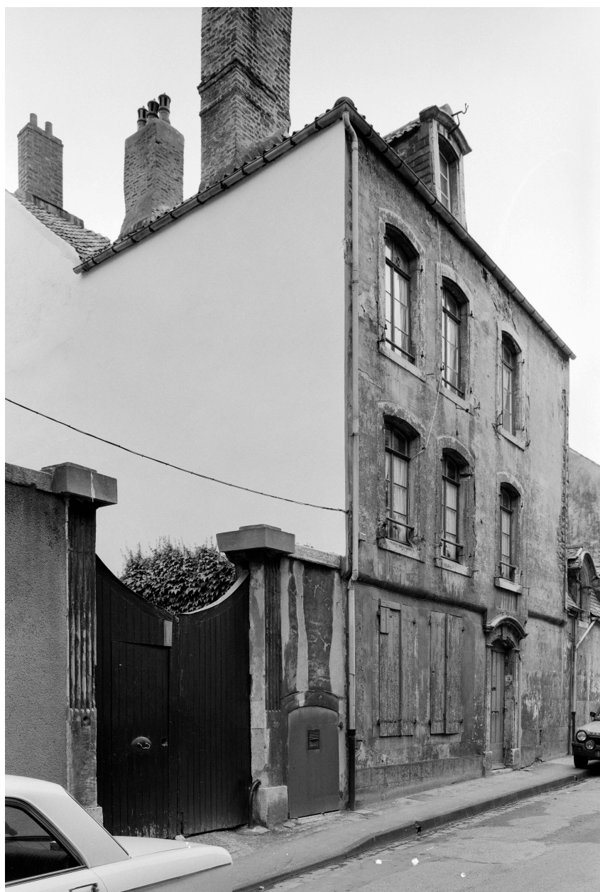
Vue d'angle sud-ouest avant restauration.
