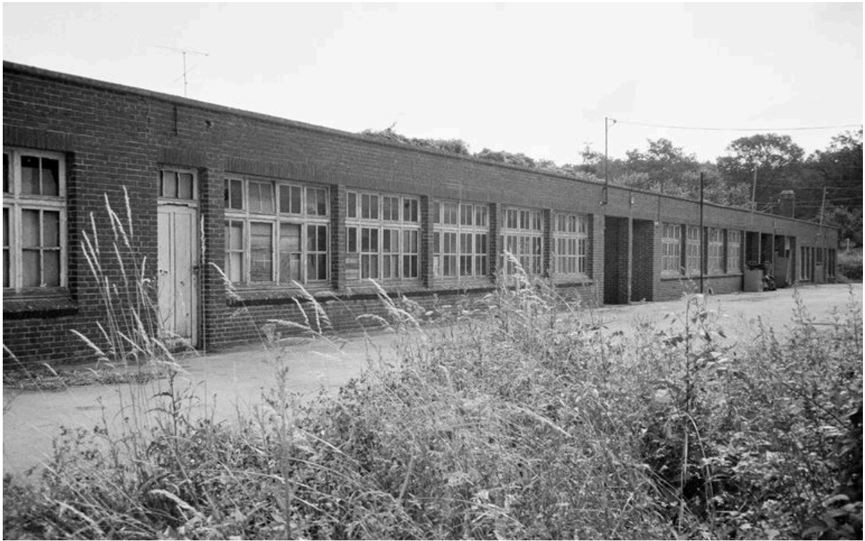
Vue générale des ateliers de fabrication subsistant en 1992.
