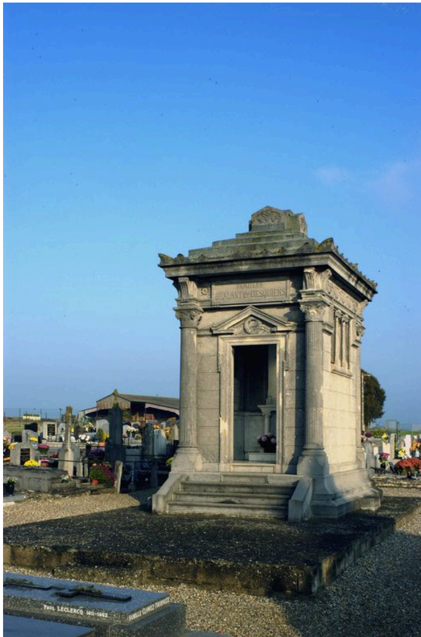
Tombeau (chapelle), vers 1892. Paul Delefortrie (architecte). Pont-de-Metz.
