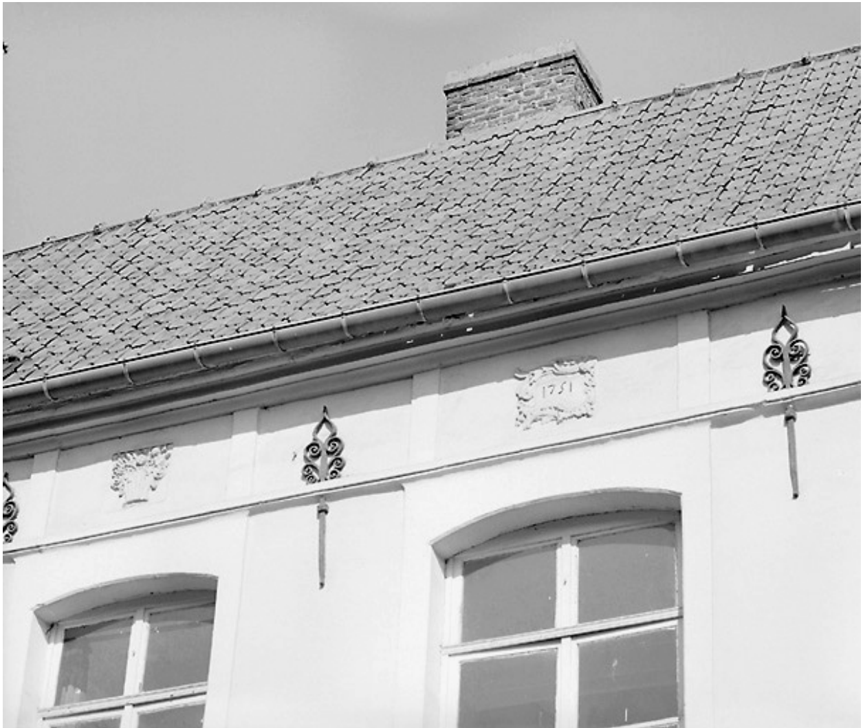
Façade rue Notre-Dame, vue partielle : table sculptée et cartouche des travées 5 et 6.
